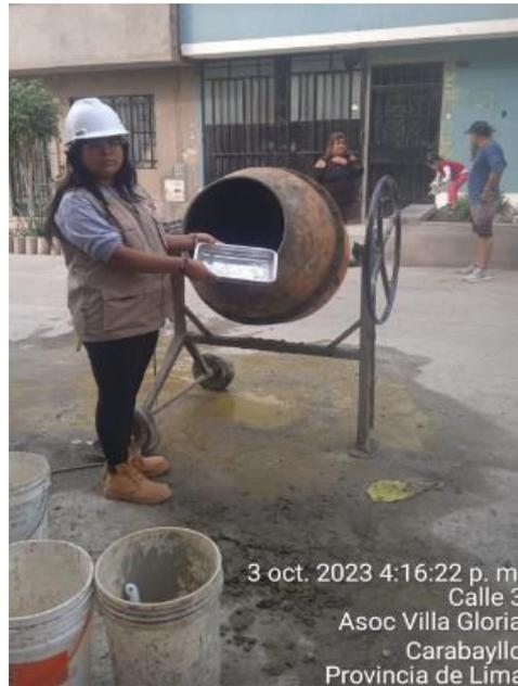
Vaciado concreto con harina de coca      Vaciado concreto con almidón de papa
