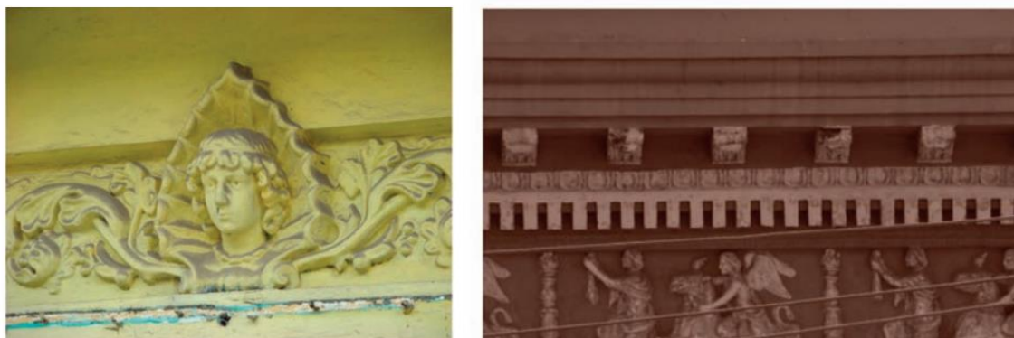
Cornisas en fachadas
