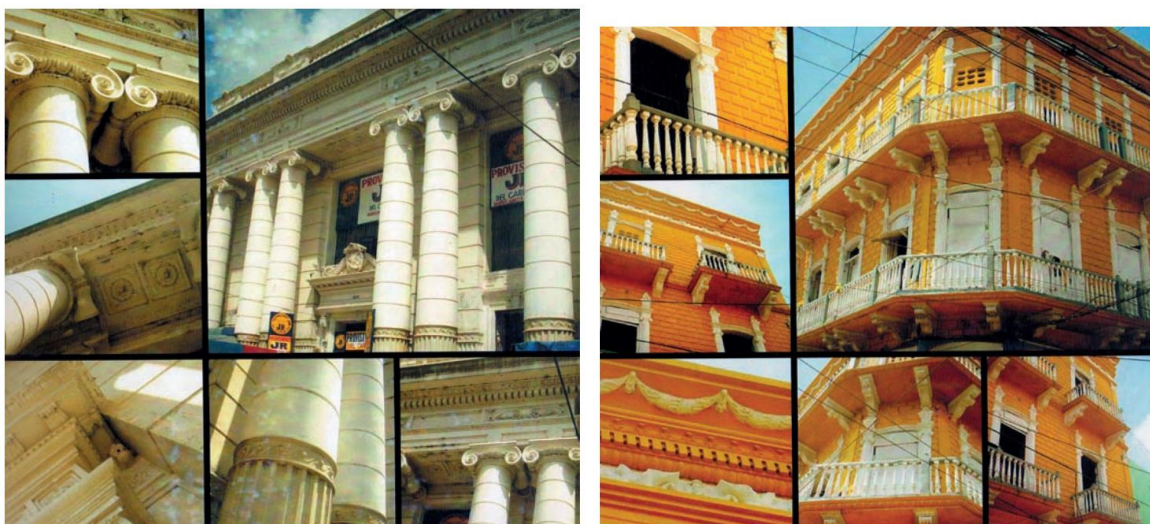
Elementos estilísticos de la fachada republicana residencial
