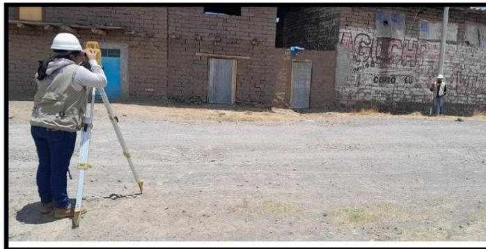
Fotografía 4: trazando puntos de para lotización.
