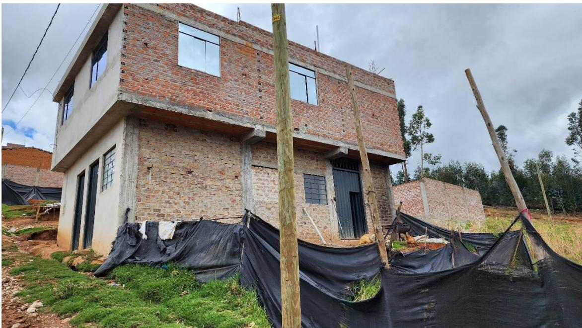
Foto N°09: Vivienda sin arriostre en elementos estructurales y no estruct.
