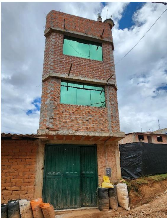
Foto N°10: Discontinuidad en elementos Estructurales.
