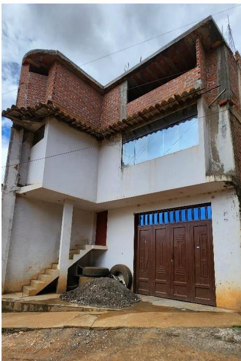
Foto N°17: Vivienda con falta de arriostre en elementos no estructurales.
