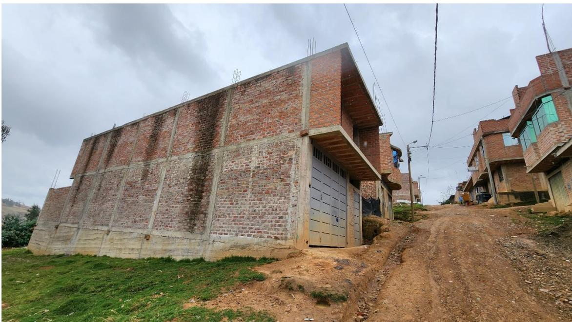
Foto N°08: Vivienda 12 muestra la falta de arriostres de los elementos estructurales y no estructurales; teniendo dos ejes con vigas peraltadas y dos ejes con vigas chatas.
