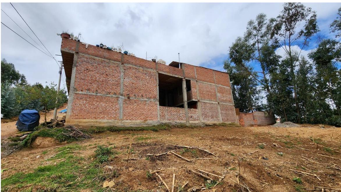
Foto N°07: Vivienda 21 muestra la humedad que discurre de los niveles superiores ocasionado por la falta de coberturas en zonas con altos índices de lluvia.
