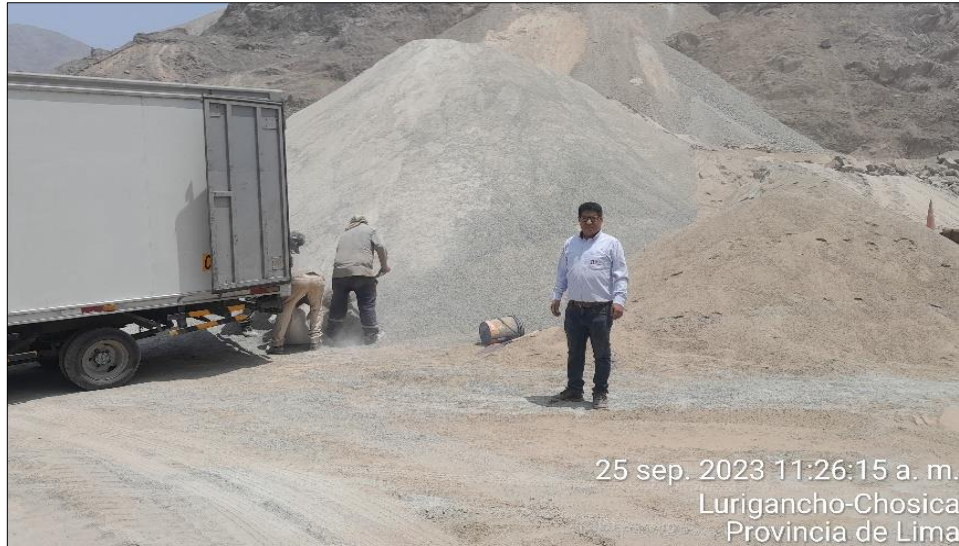
Figura n.10 Recojo de agregados de puntos acopiados dentro de la cantera.
