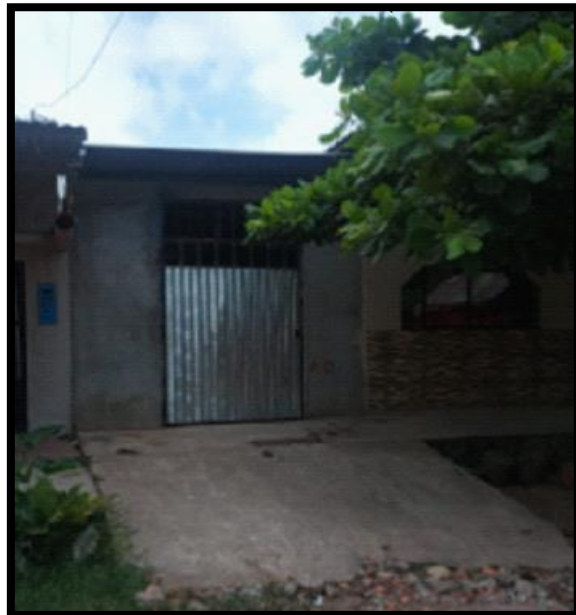
Figura 164. Mz. A – Av. Miraflores y Circunvalación John F. Kennedy Fuente: Elaboración propia
