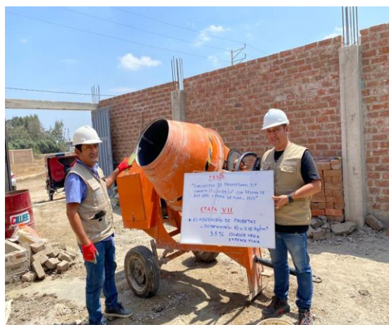
Figura 20 Dosificación de concreto muestra patrón con incorporación la adición de resina de aloe vera y penca de tuna
