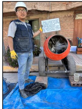
*Figura 18. Agregando fibra de vidrio a la mezcla.*
