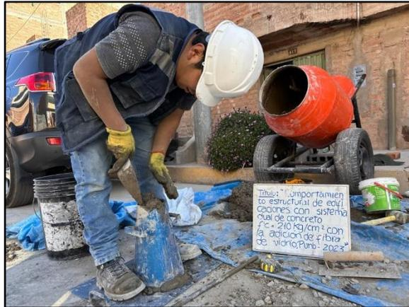
Figura 20. Prueba de Slump antes de verter en los moldes cilíndricos
