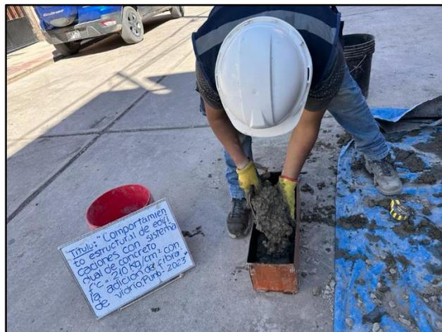
Figura 27. Llenado en los moldes prismáticos de flexión.
