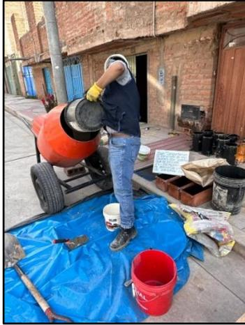
*Figura 23. Preparando la mezcla para vigas prismáticas.*
