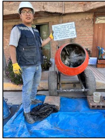
*Figura 24. Agregando fibra de vidrio a la mezcla.*
