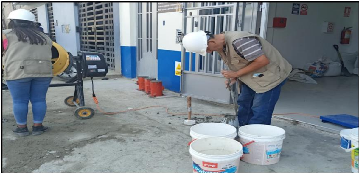
Figura 17. proceder a situar el hormigón dentro del recipiente de medición asignado
