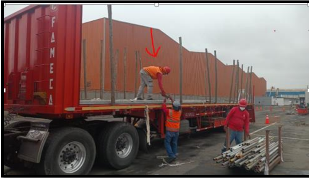
Figura 7. Foto de exposición a riesgos de caída de primer y segundo nivel
