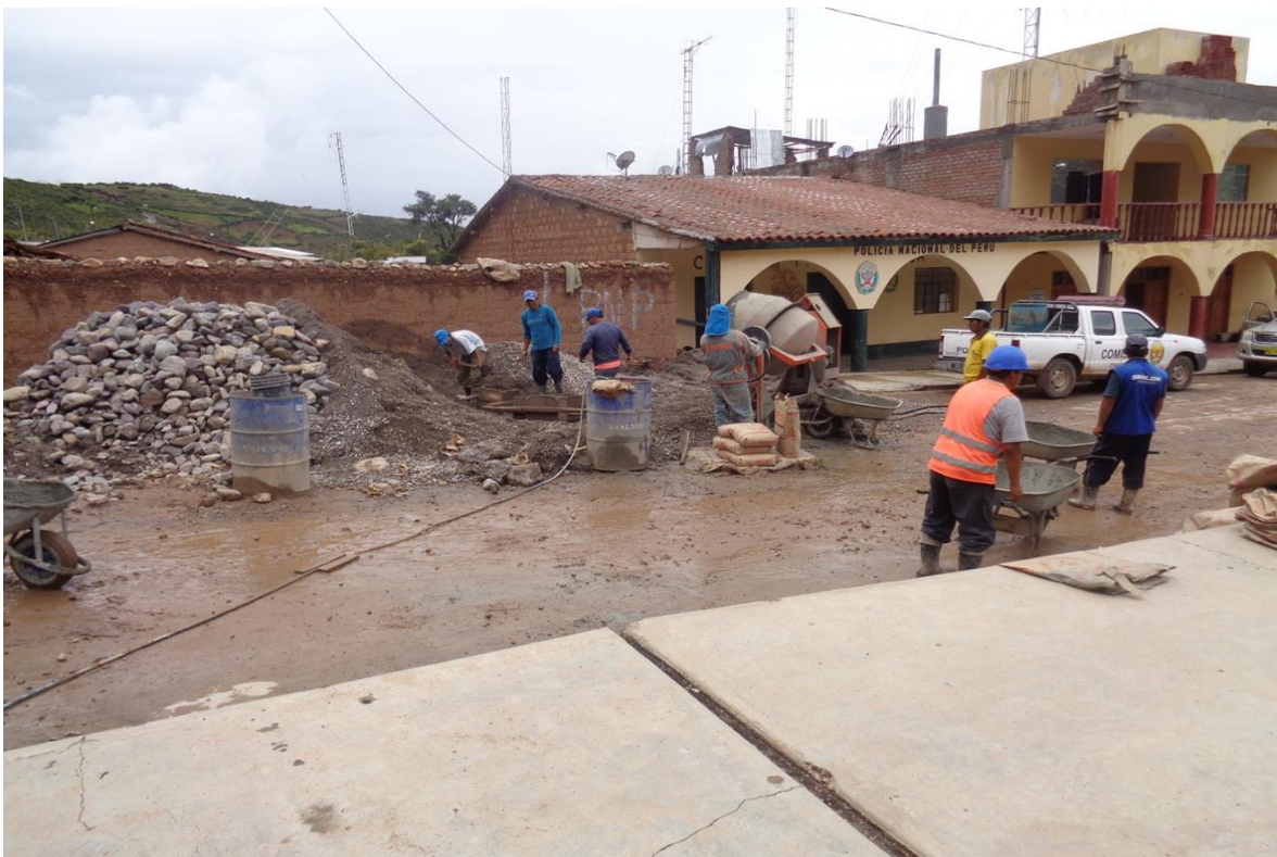
Descripción: Se observa los cilindros metálicos con presencia de óxido de hierro
