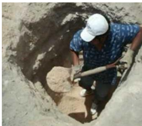
Fig.3.4: Excavación de calicata
