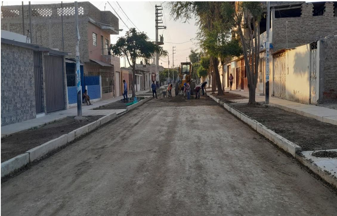
Figura: Rectificación de base granular.
