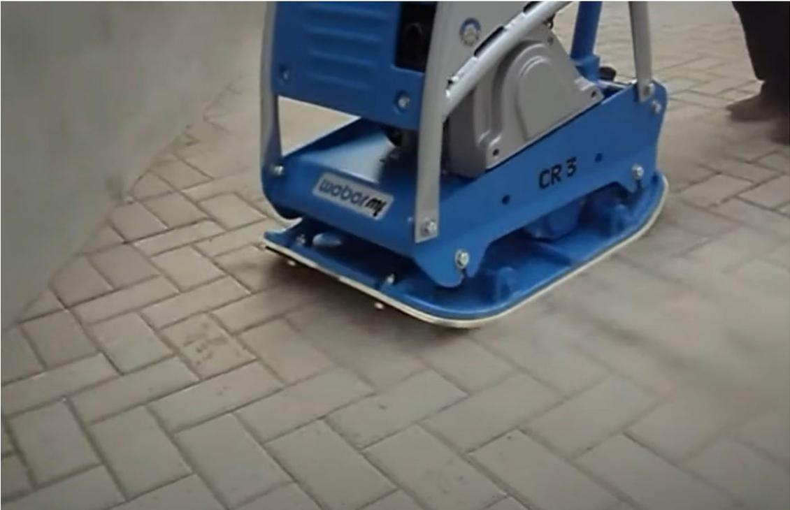
Figura: Vibración de carpeta adoquinada.
