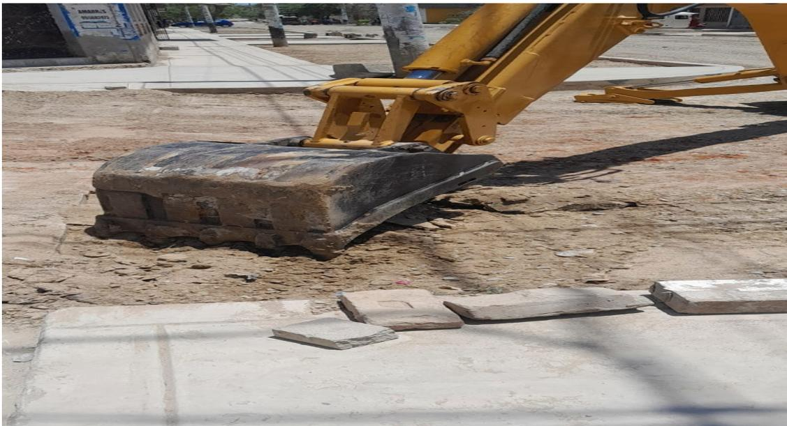
Figura: Demolición de la carpeta asfáltica presente.
