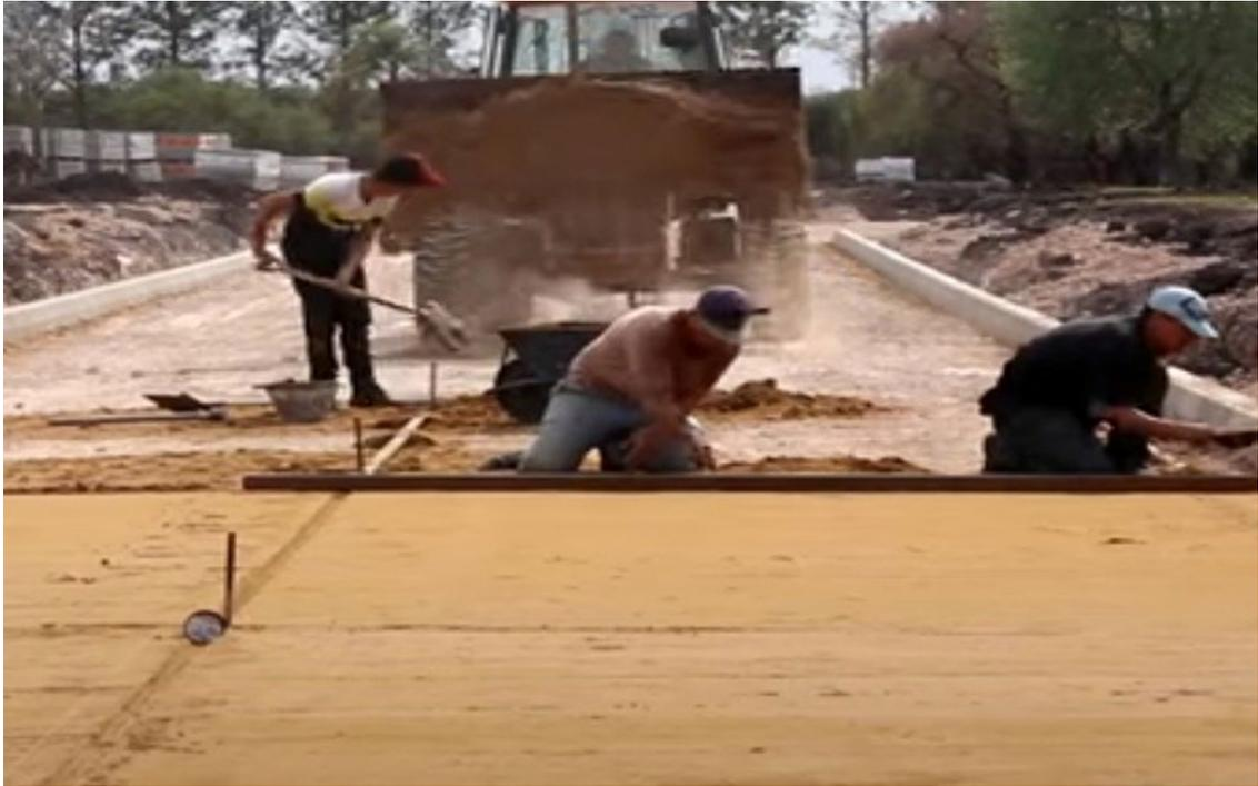
Figura: Colocación de Base Granular.
