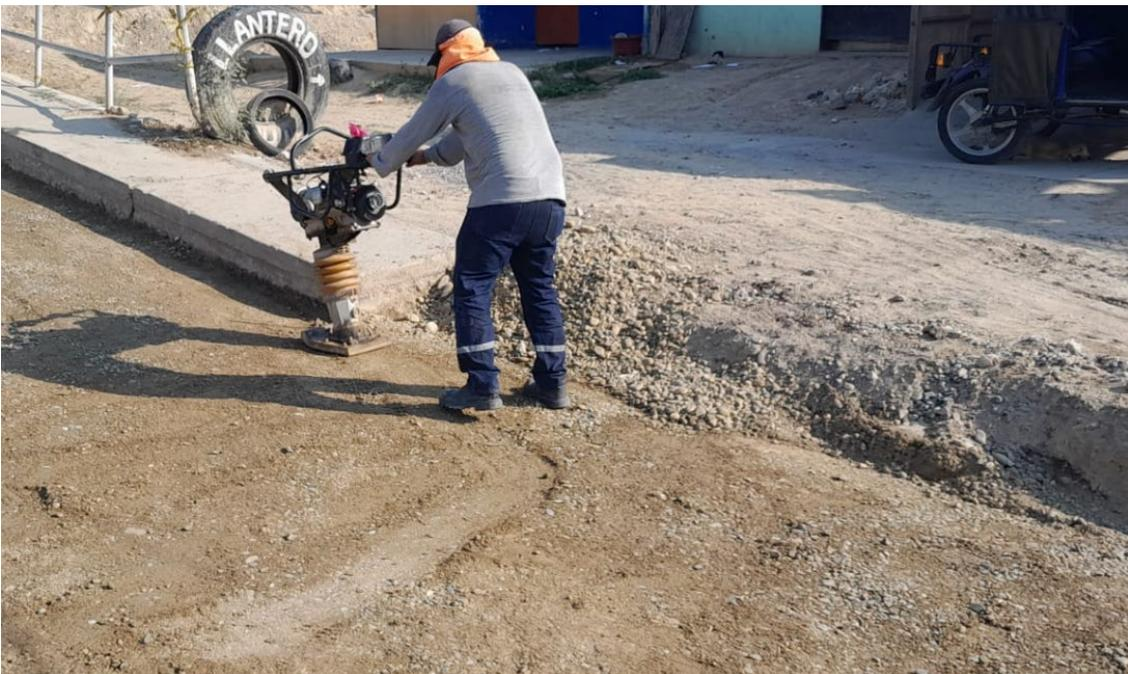
Figura: Compactación de base granular con apisonador.
