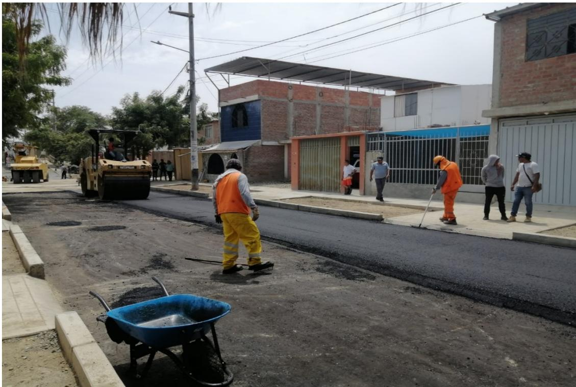
Figura: Compactación de carpeta asfáltica.
