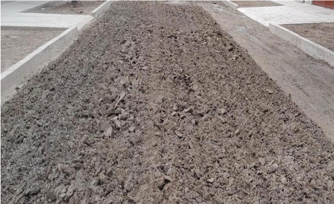
Figura: Nivelación de Base Granular.
