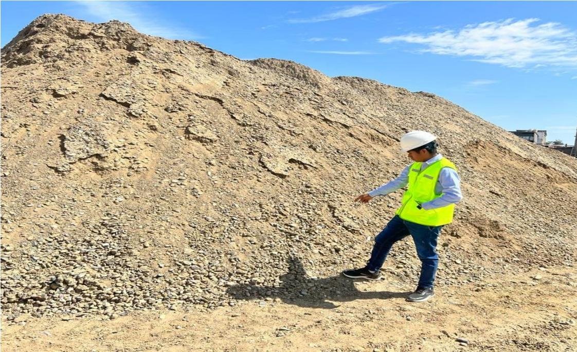
Figura: Agregado utilizado en la base granular de pavimento flexible.
