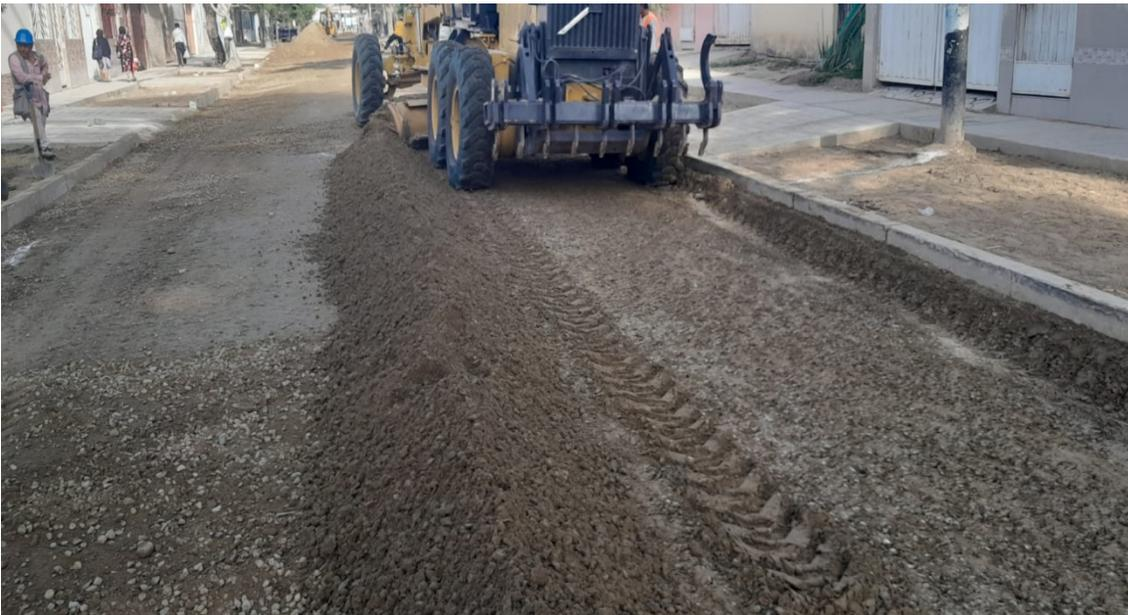
Figura: Inicio de colocación de base granular.
