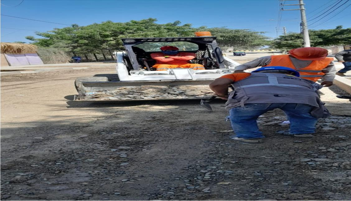
Figura: Eliminación de material excedente.
