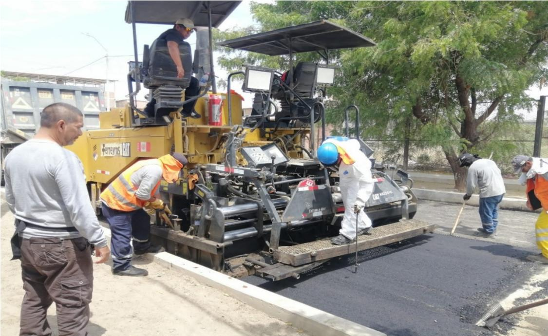
Figura: Inicio de imprimación asfáltica.
