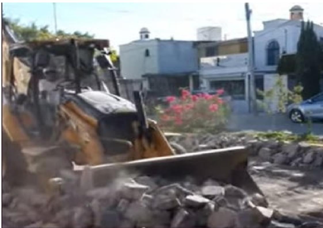
Figura: Demolición de la carpeta existente.
