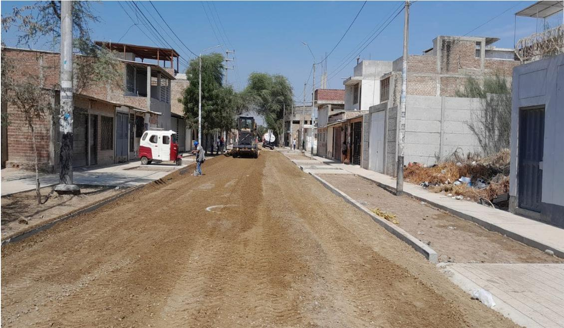
Figura: Fin de colocación de base granular.
