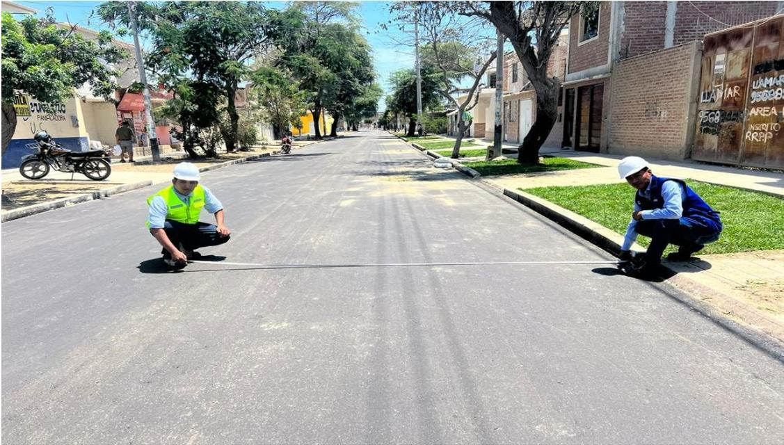
Figura: Medición de carpeta asfáltica terminada.
