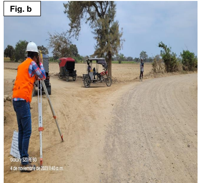
Nota: Fig. Levantamiento topográfico de trocha carrozable, Fig. b. Tomando lecturas en puntos en campo.
