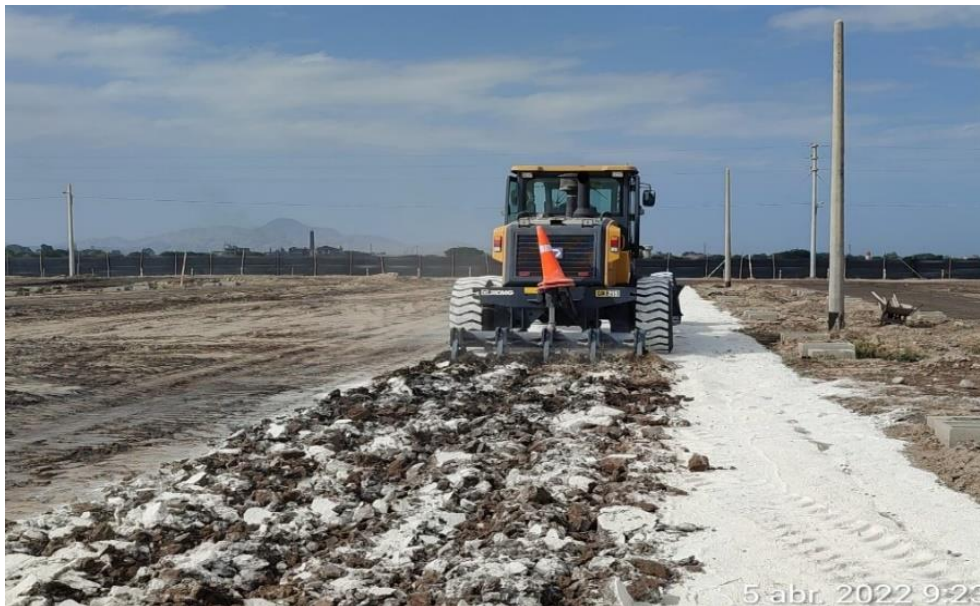
Figura 19 Mejoramiento de Suelos con Cal
