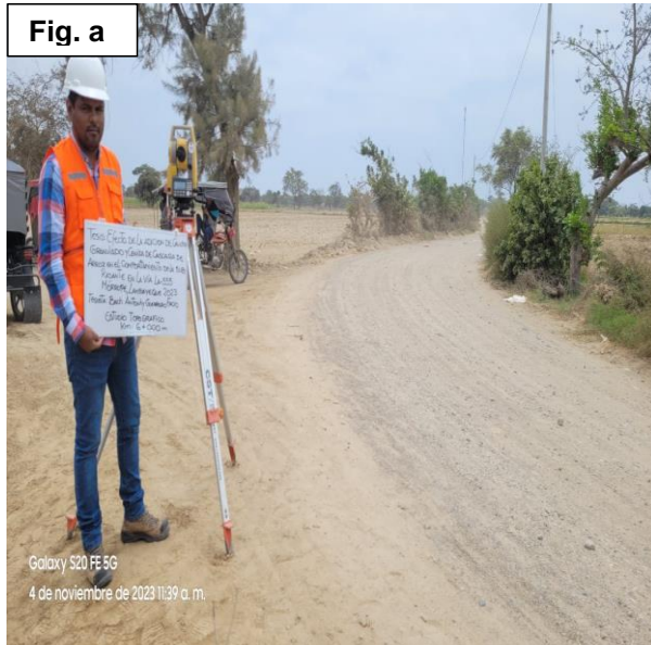
Nota: Fig. Levantamiento topográfico de trocha carrozable, Fig. b. Tomando lecturas en puntos en campo.
