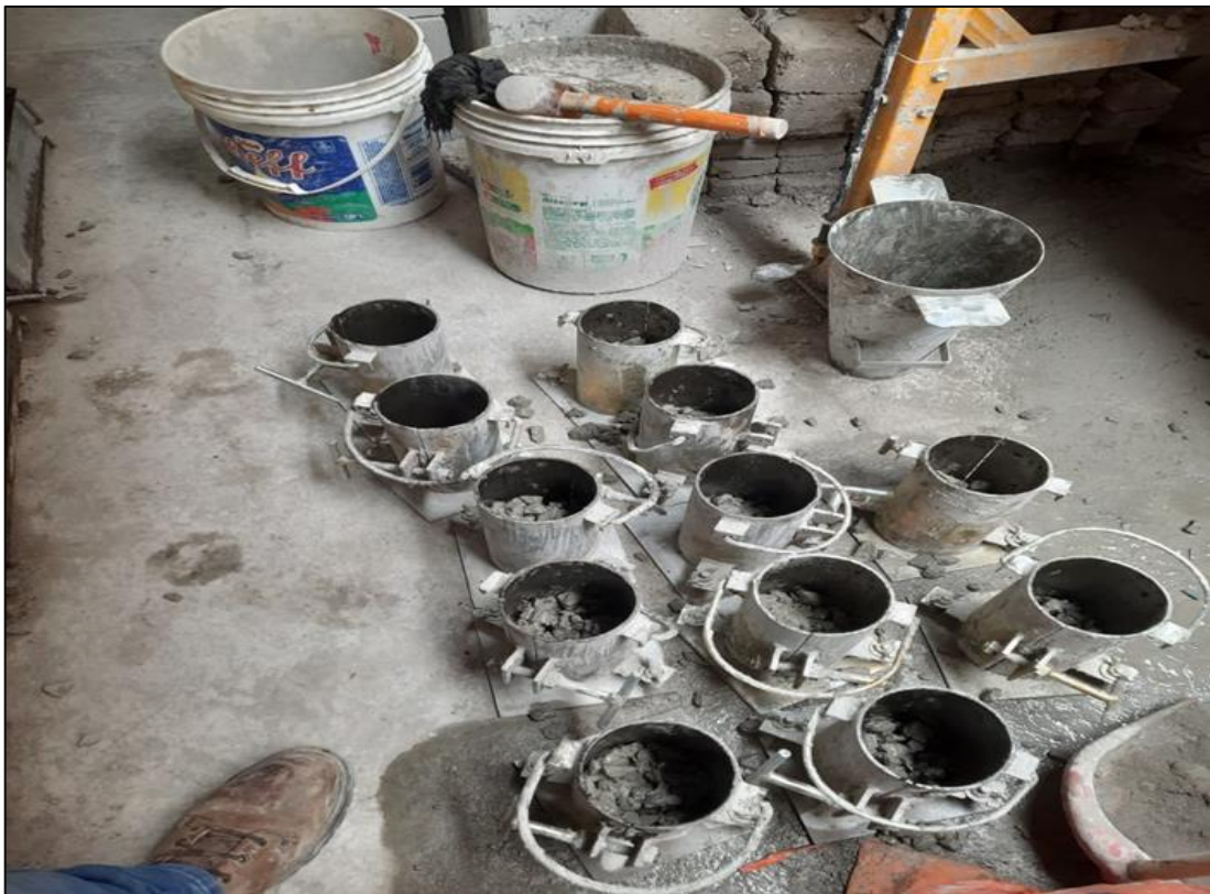
Fotografía 8. Llenando las probetas con concreto permeable
