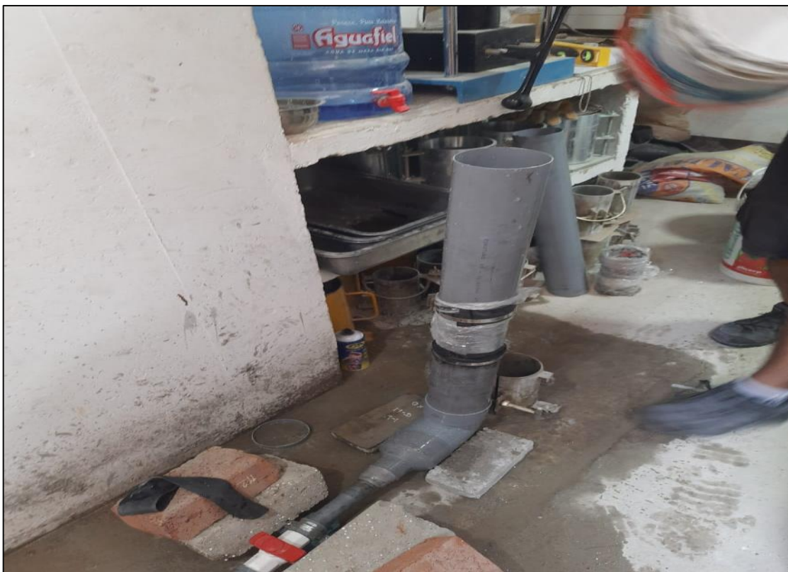
Fotografía 14. Ensayo de permeabilidad
