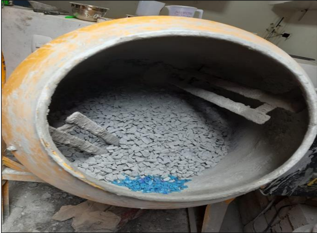
Fotografía 5. Adición de polietileno a la mezcla de concreto permeable
