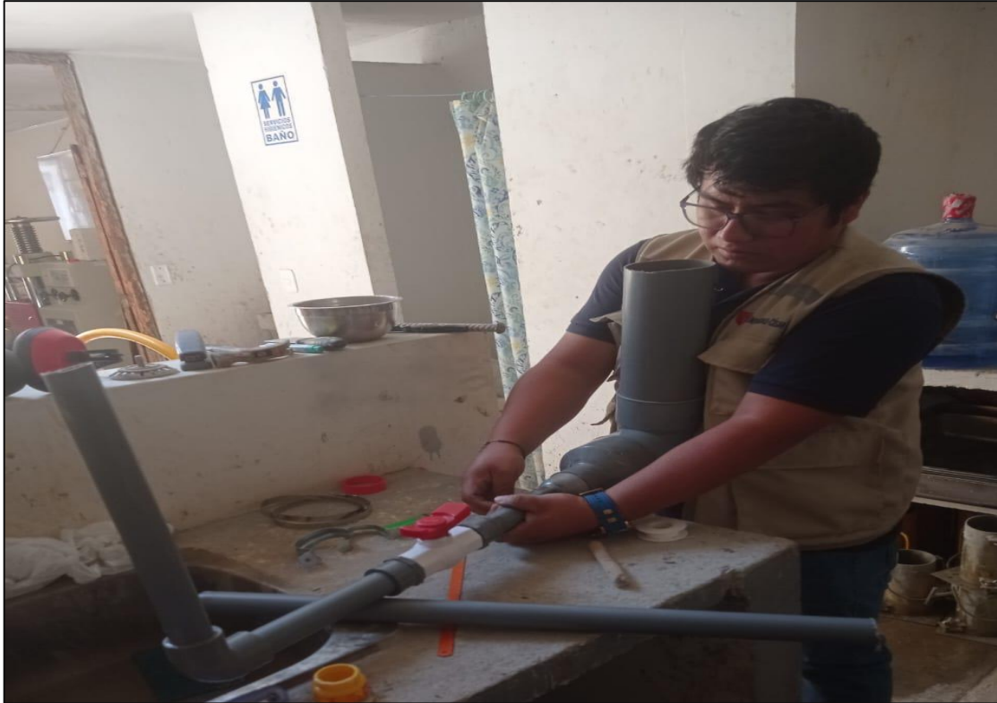
Fotografía 13. Elaboracion del equipo para realizar la prueba de permeabilidad
