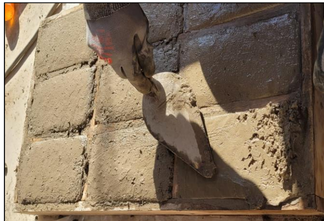
Elaboración de adoquines de concreto reciclado y viruta de acero
