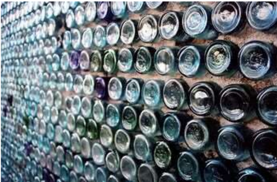
FIGURA 5: Muro a base de botellas de vidrio
