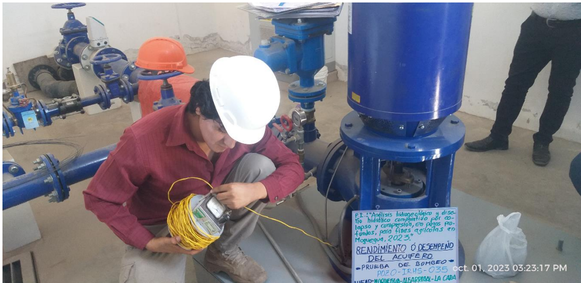
Prueba de bombeo o desempeño del acuífero, en estación de bombeo POZO IRHS-035.
