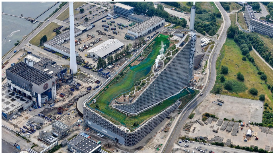
Figura 12 Planta de Tratamiento Amager - Copen Hill
