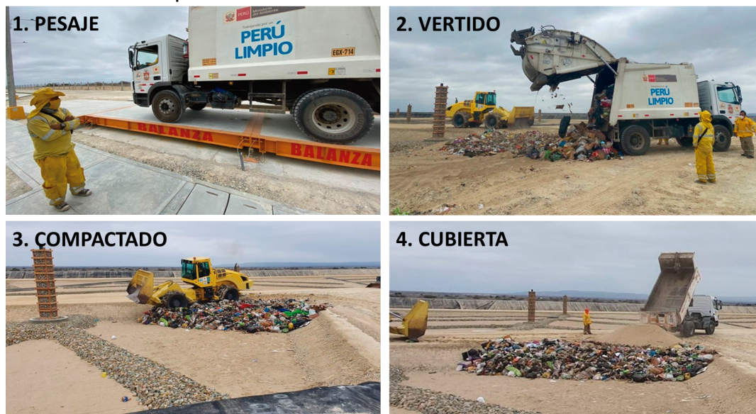
Gobierno del Perú-Relleno sanitario Paita
