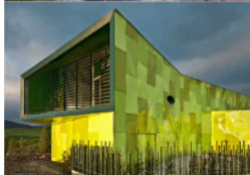
Central de Recogida de Residuos de Pamplona, España. https://lc.cx/L2by8A
