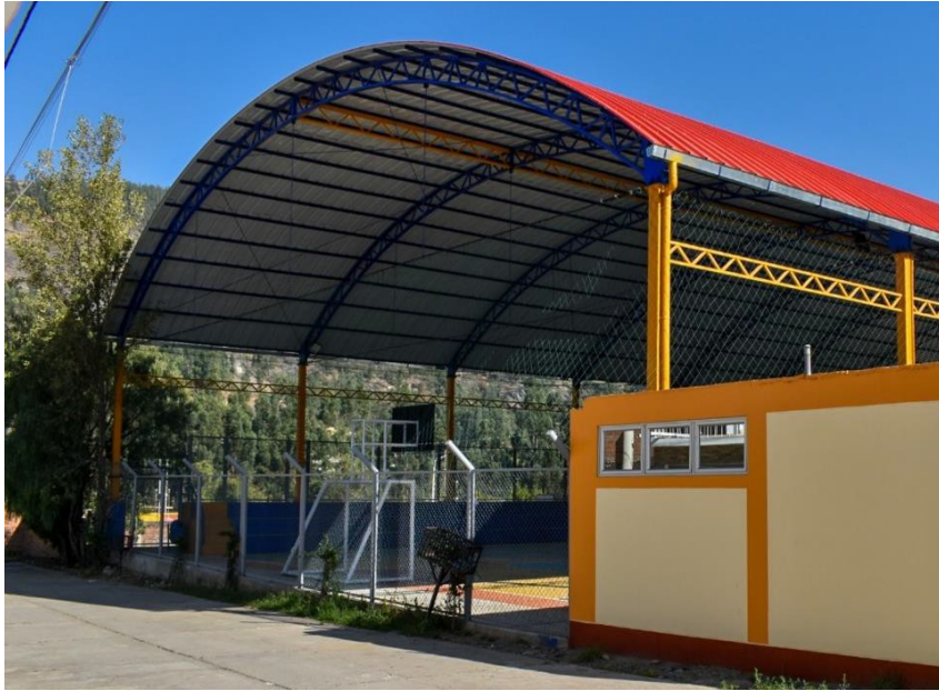
Figura 24. Campo deportivo de futbol sin un acceso seguro.
