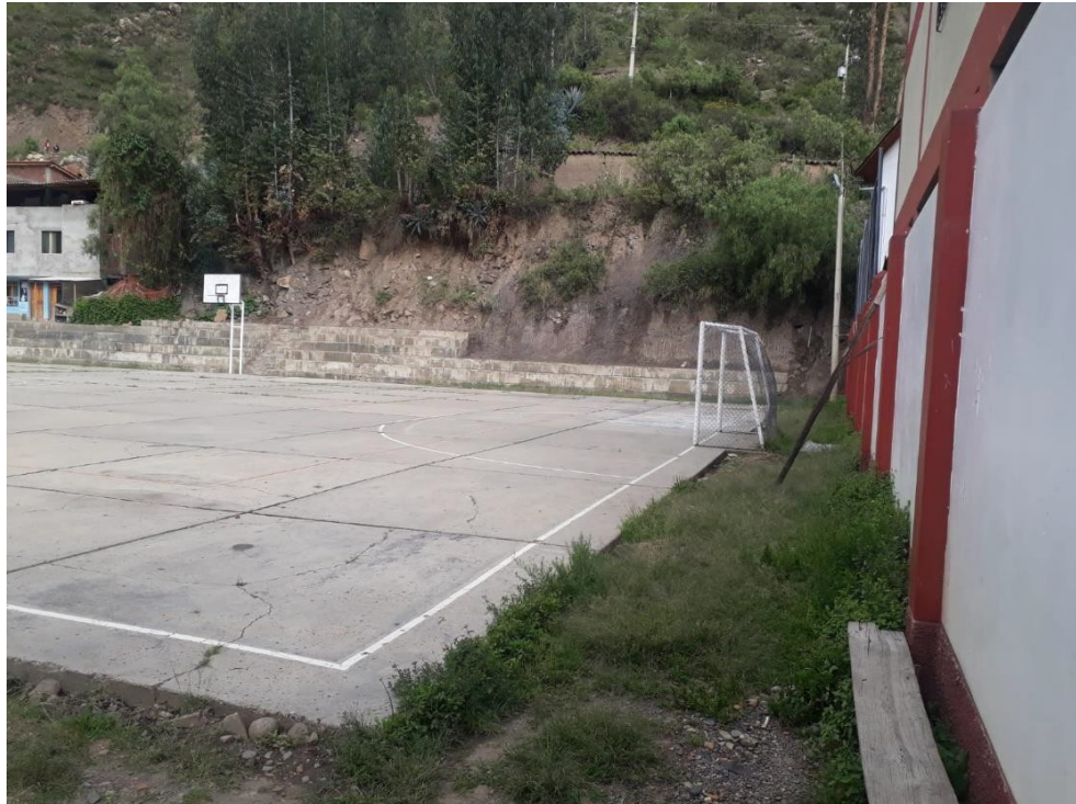
Figura 23. Campo de fulbito deteriorado
