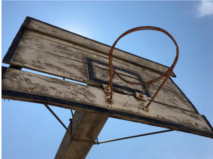
Figura 30. Falta de mantenimiento del mobiliario deportivo
