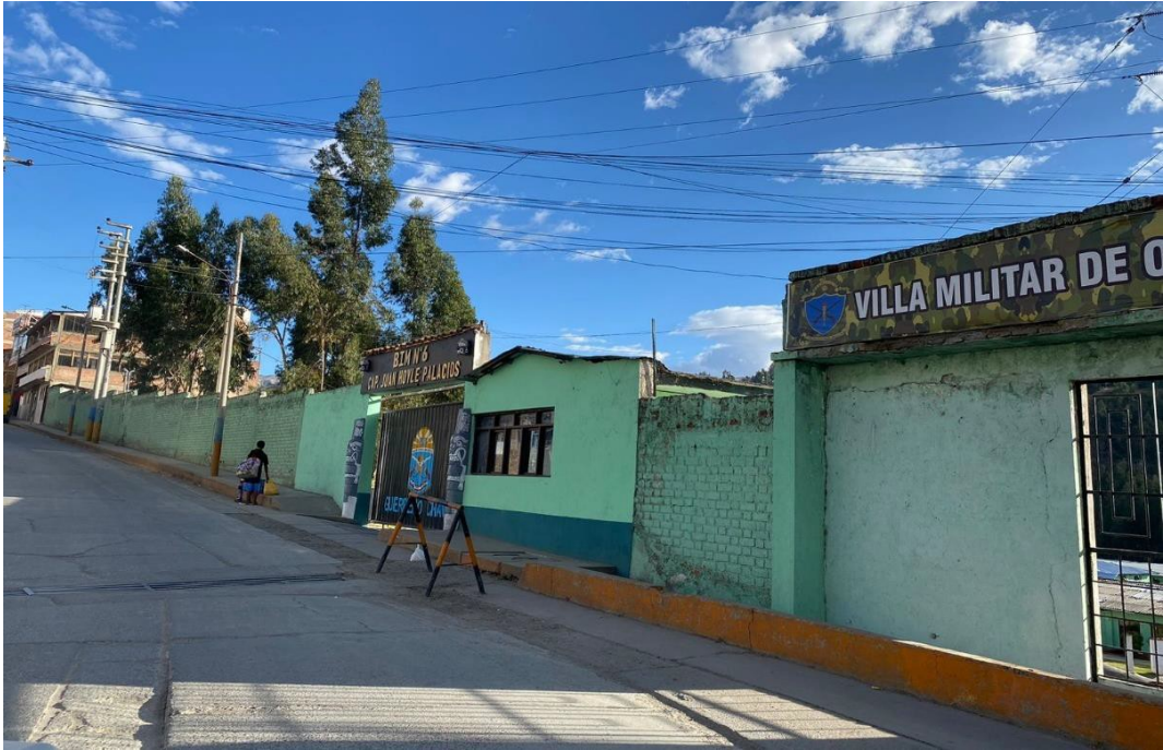
Figura 28. Alteración del paisaje urbano por cerco perimétrico inadecuado.
