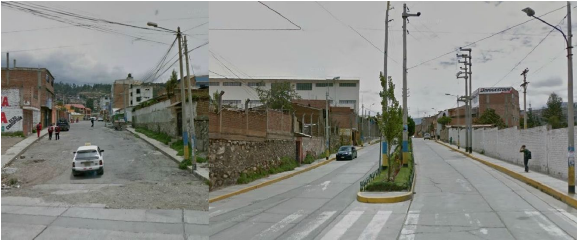
Figura 19. Veredas y vías deterioradas
