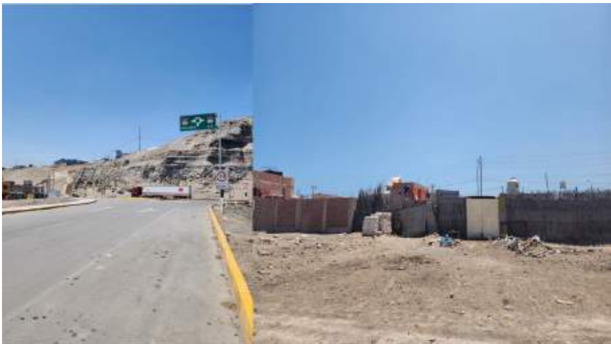
Figura 21. Vía interprovincial y vías locales sin asfalto.
