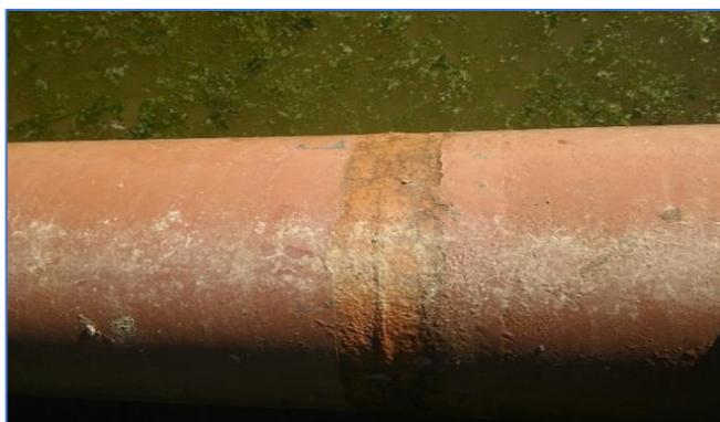
**Figura 4:** Tubería con inicio de corrosión
