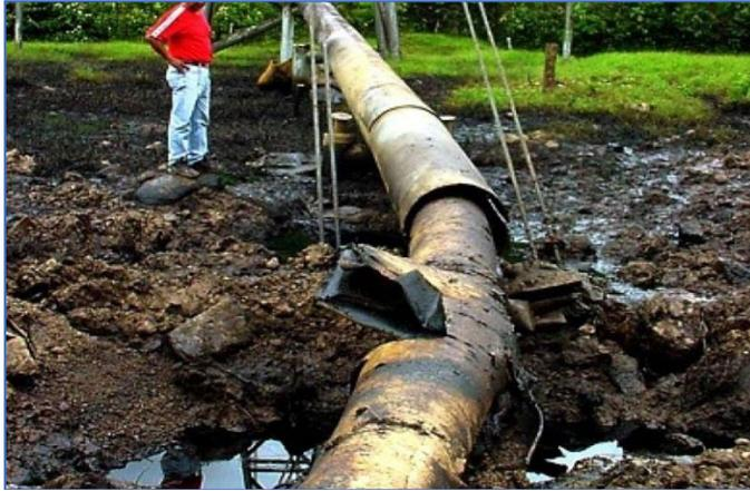
**Figura 3:** Destrucción de Tubería por corrosión
