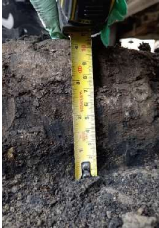
Figura 11. Medición de profundidad de zanja
