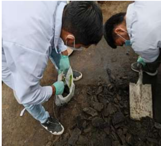
Figura 10. Excavación de zanja
