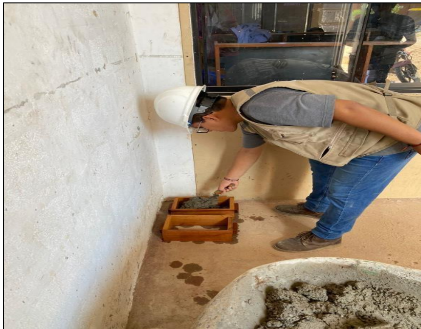
IMAGEN 09: En las imágenes podemos observar al personal realizando moldeo de los bloques de concreto.
