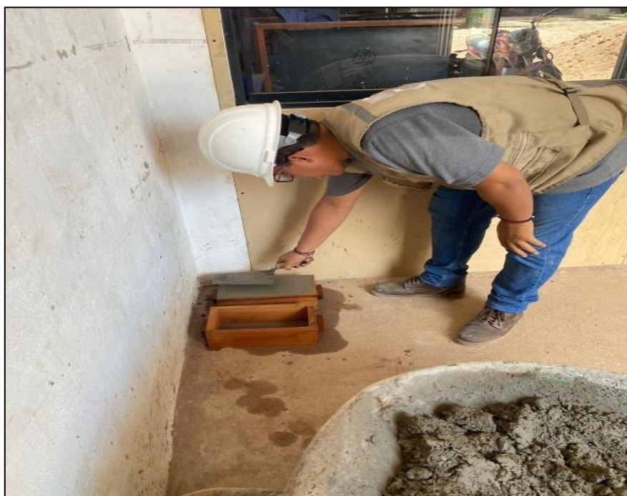
IMAGEN 10: En las imágenes podemos observar al personal realizando moldeo de los bloques de concreto.
