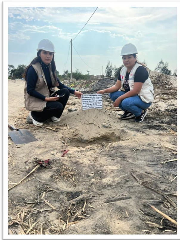
Excavación para obtener muestras en la C-01
