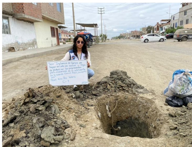
Figura 3: Excavación de calicatas
