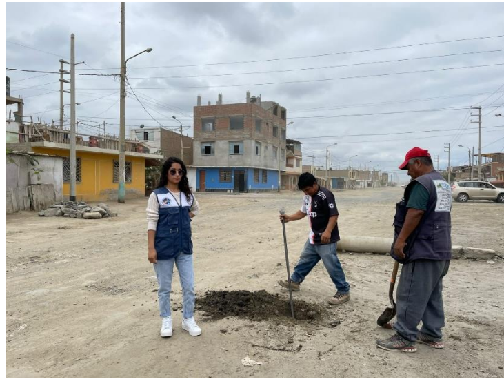
Figura: Ubicación de calicatas
