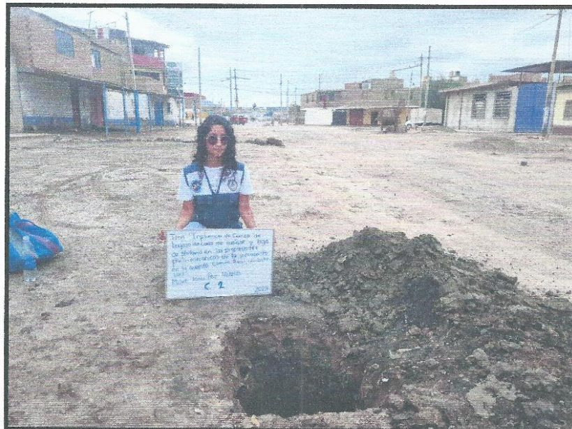
FOTOS N° 04, 05 y 06: Excavación manual de Calicata N° 02
