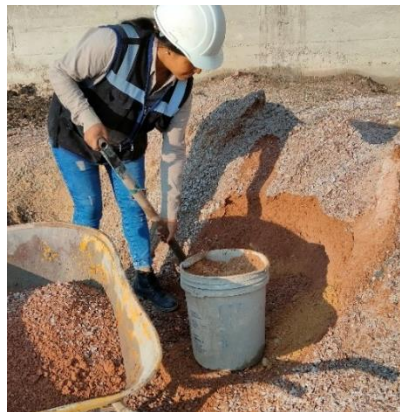
Figura 8. Hormigón de cerro.
