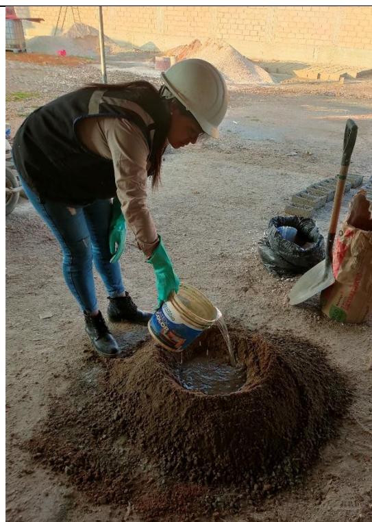
Figura 10: Adición de agua.
