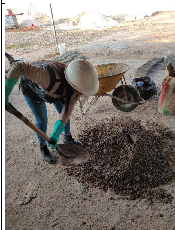
Figura 11: Mezcla para elaboración de ladrillos.
