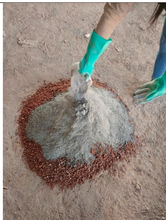
Figura 8: Medición de los agregados.
