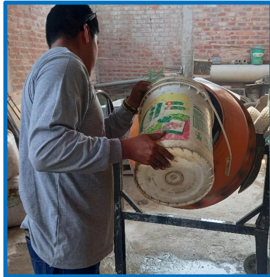
Imagen 33 y 34: Incorporación de cemento y agua a la mezcla.
