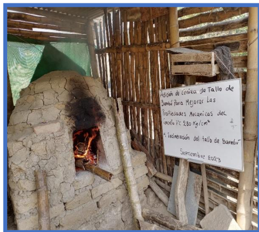
Imagen 25 y 26: Tesistas en Limpieza de horno e incineración de la materia prima
