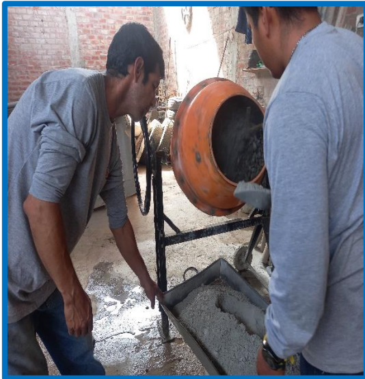
Imagen 33 y 34: Incorporación de cemento y agua a la mezcla.
