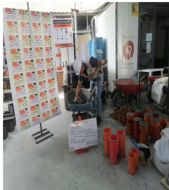
**Imagen N°36: CHICLAYO.** Elaboración de probetas, adición de 0.3% fibra de polipropileno, 2023.
