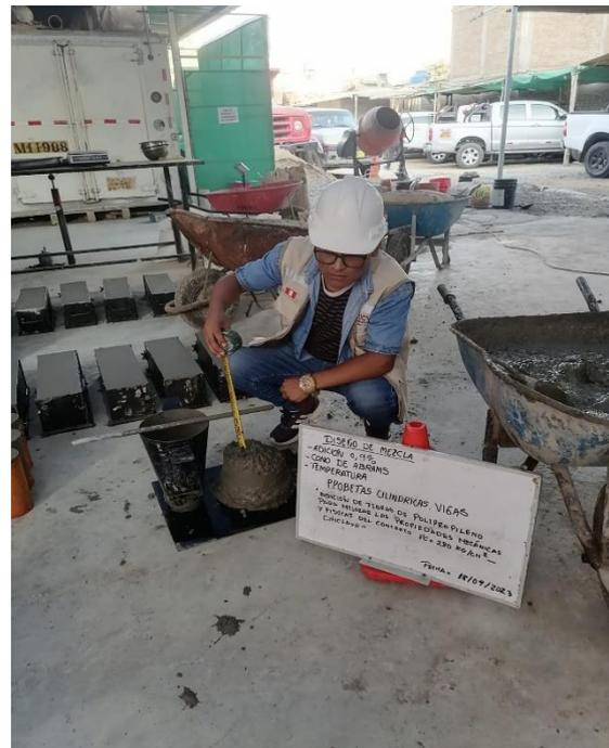
**Imagen N°39: CHICLAYO.** Ensayo de asentamiento (slump), adición de 0.9% fibra de polipropileno, 2023.
