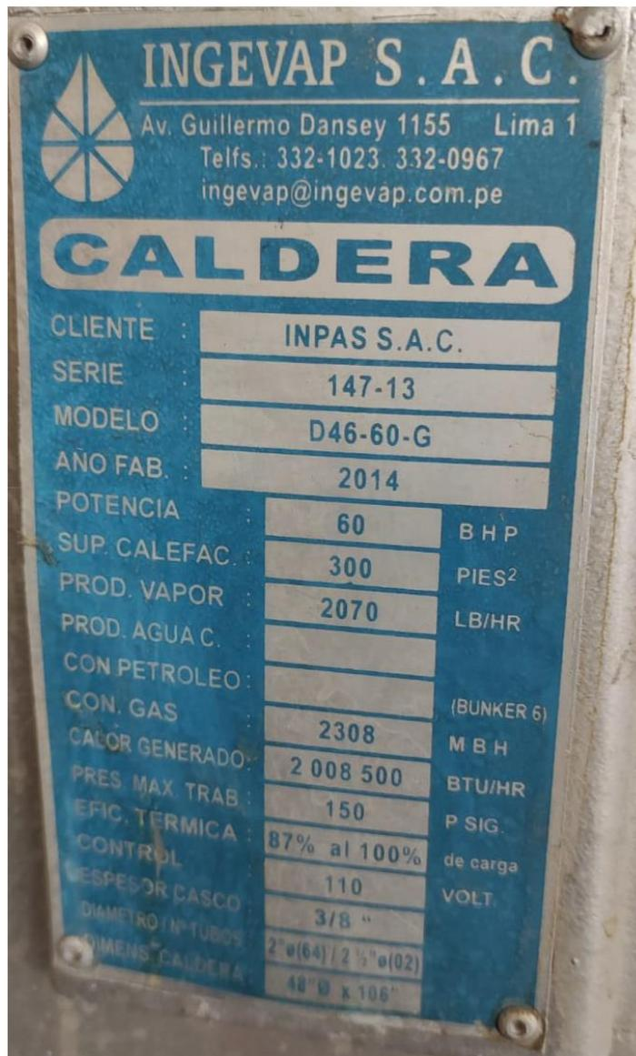
Figura 5. Datos de placa de caldera en H. Las Mercedes
