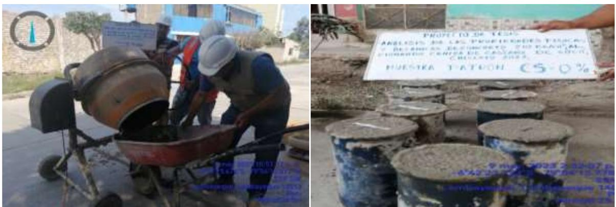
Figura 13. Obtención de 9 muestras patrón de resistencia  $f'c=210\text{kg/cm}^2$
