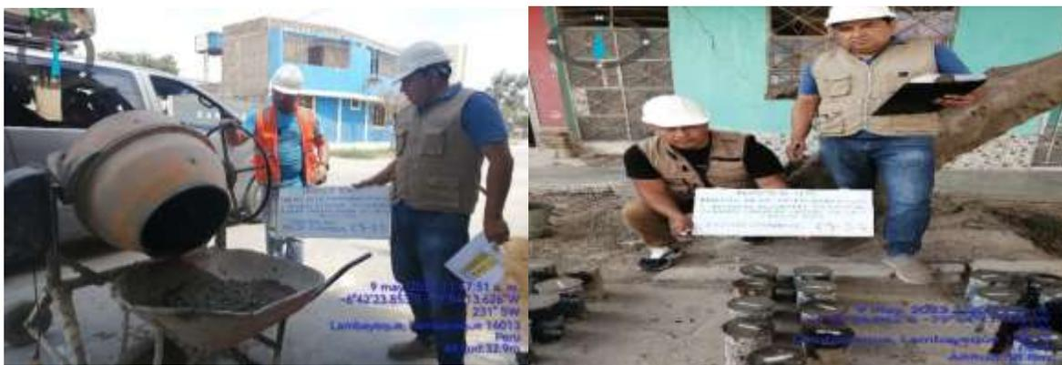
Figura 14. Obtención de 09 Muestras experimentales con 5% de Ceniza de cascara de coco
