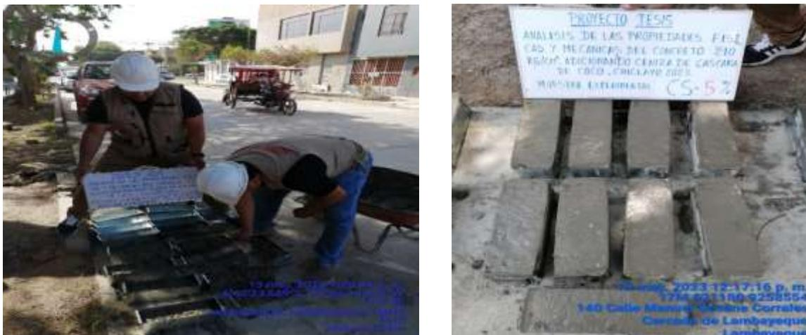
Figura 19. Obtención de 09 Muestras experimentales con 5% de Ceniza de cascara de coco
