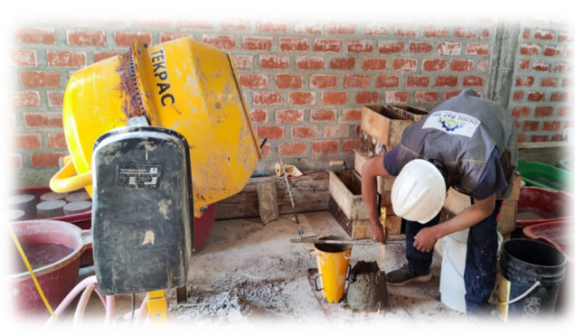
Figura06: Medición de slump.
