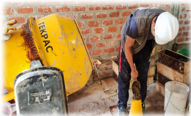
Figura05: Muestreo de slump.
