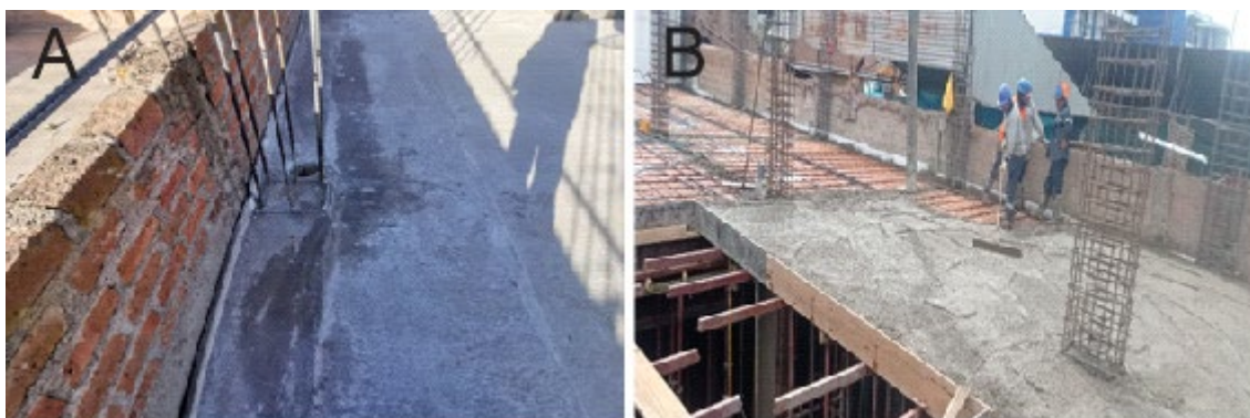
Figura 2. Edificación expuesta a la helada, Región de Puno.
