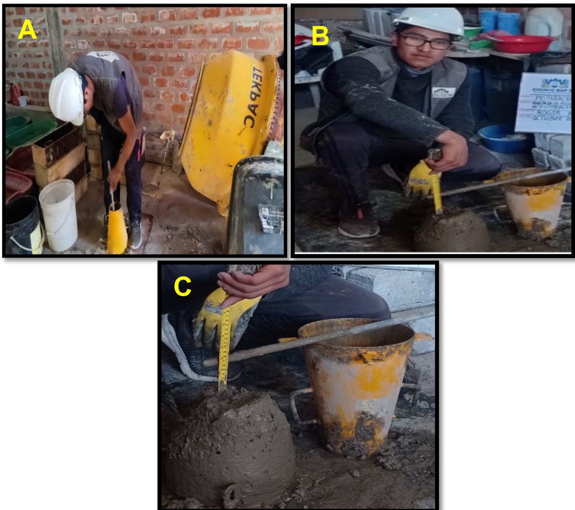
Figura 20 . Prueba de Slump
