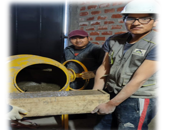
Figura10: Llenado de vigas.
