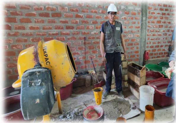
Figura07: Prueba del cono invertido.
