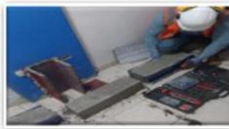
FOTO N°14: DESENCOFRADO DE VIGAS PRISMATICAS
