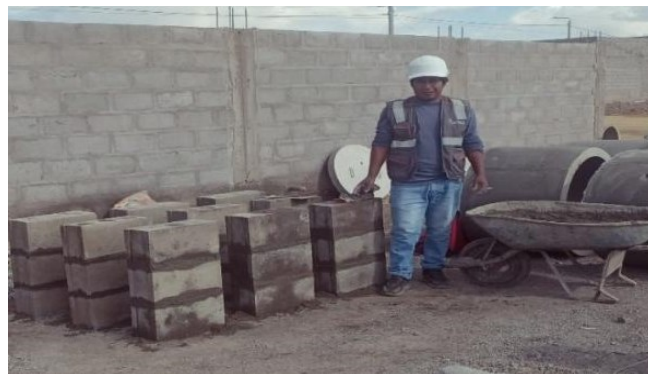
Figura 19. Elaboración de pilas
