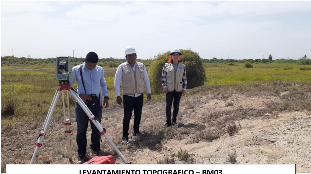
LEVANTAMIENTO TOPOGRAFICO – BM03
