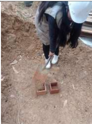
Mezcla en los moldes cúbicos
