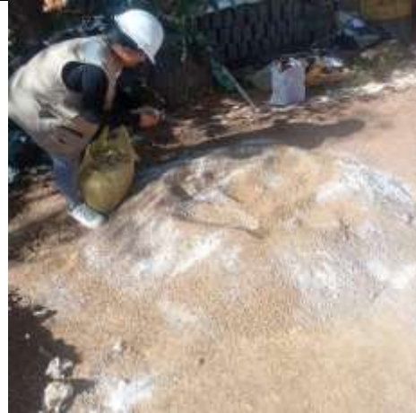
Vertido de cal hidratada
