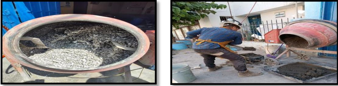
Figura 15 : *EPS con la arena y cemento, obtención de mortero, imagen propia*
