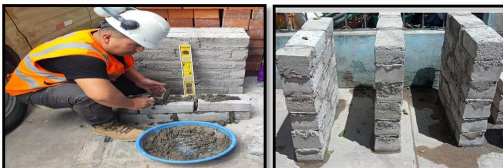
Figura 19 : Asentado de ladrillo para muretes, imagen propia
