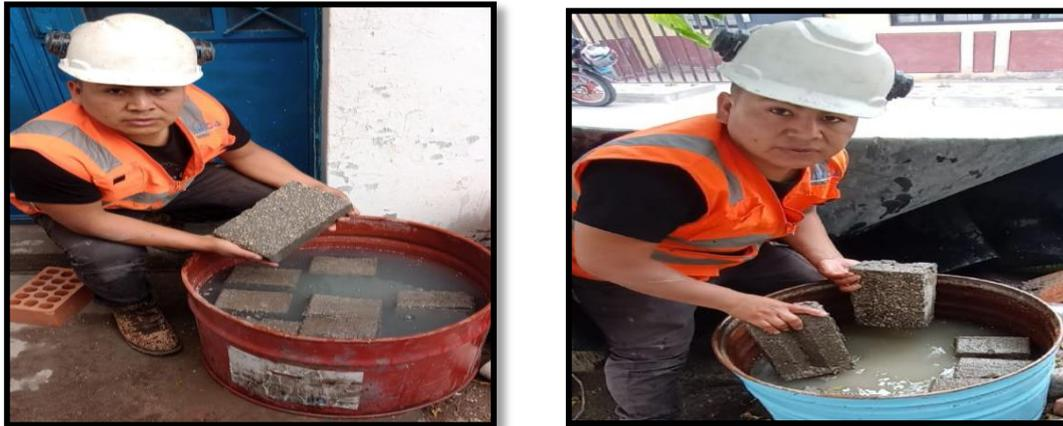
Figura 17 : *Curado en agua de ladrillos de concreto*
