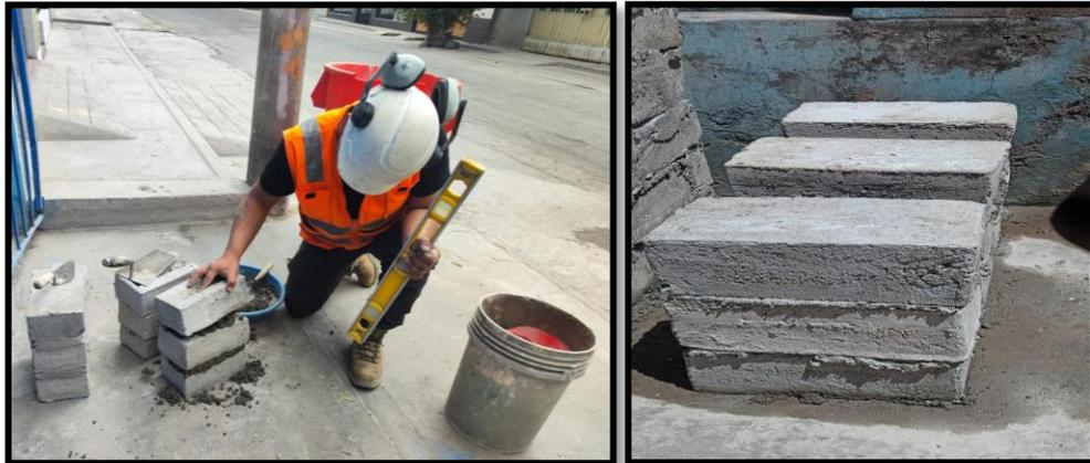
Figura 18 : Asentado de ladrillo para pilas, imagen propia
