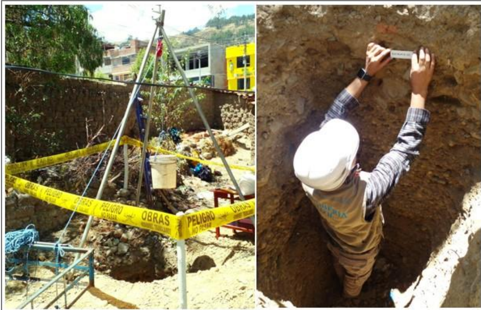
Figura 18. Ejecución de la Calicata, View estratos. Fuente: Elaboración propia.
