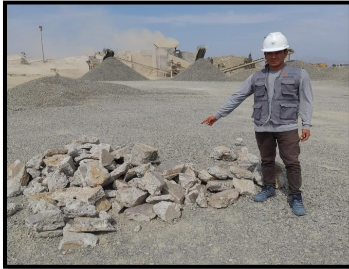
Figura 5. Disposición del concreto en la chancadora "La Palma", Ferreñafe, Evidencia fotográfica, 2022
