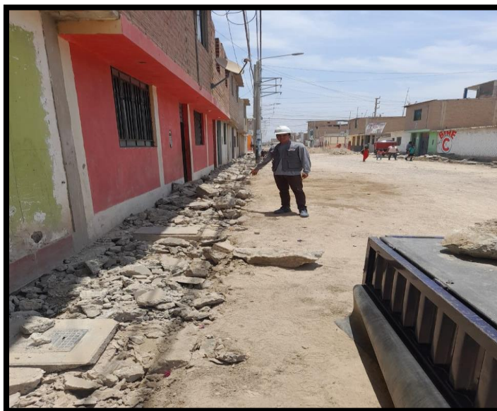
Figura 3. Obtención del concreto reciclado, en Ferreñafe Av. tres marías y Av. Huáscar, Por extracción manual, evidencia fotográfica, 2022
