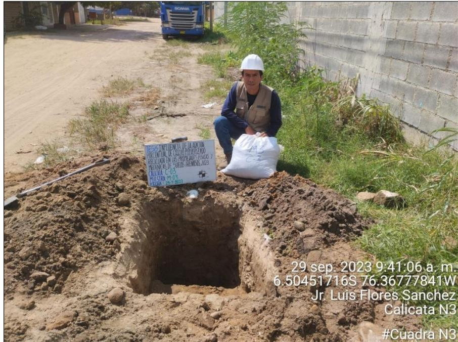
Fotografía 2: Ensayo de contenido de humedad natural
