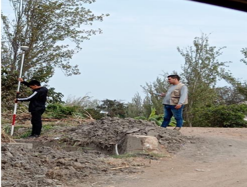
Figura 09: Levantamiento de Canal de Concreto.
