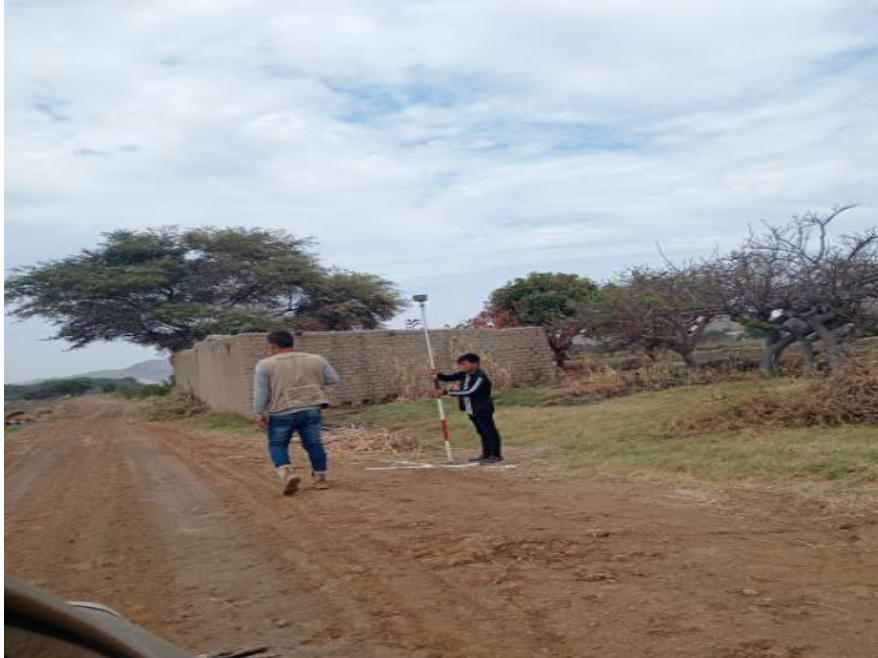
Figura 11: Levantamiento de hombros de canal.
