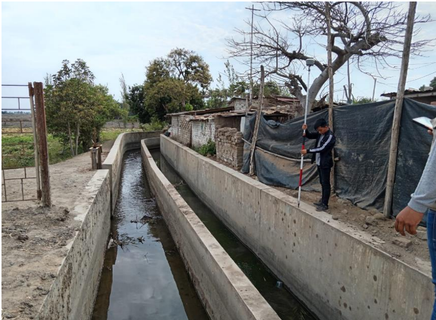
Figura 09: Levantamiento de Canal de Concreto.
