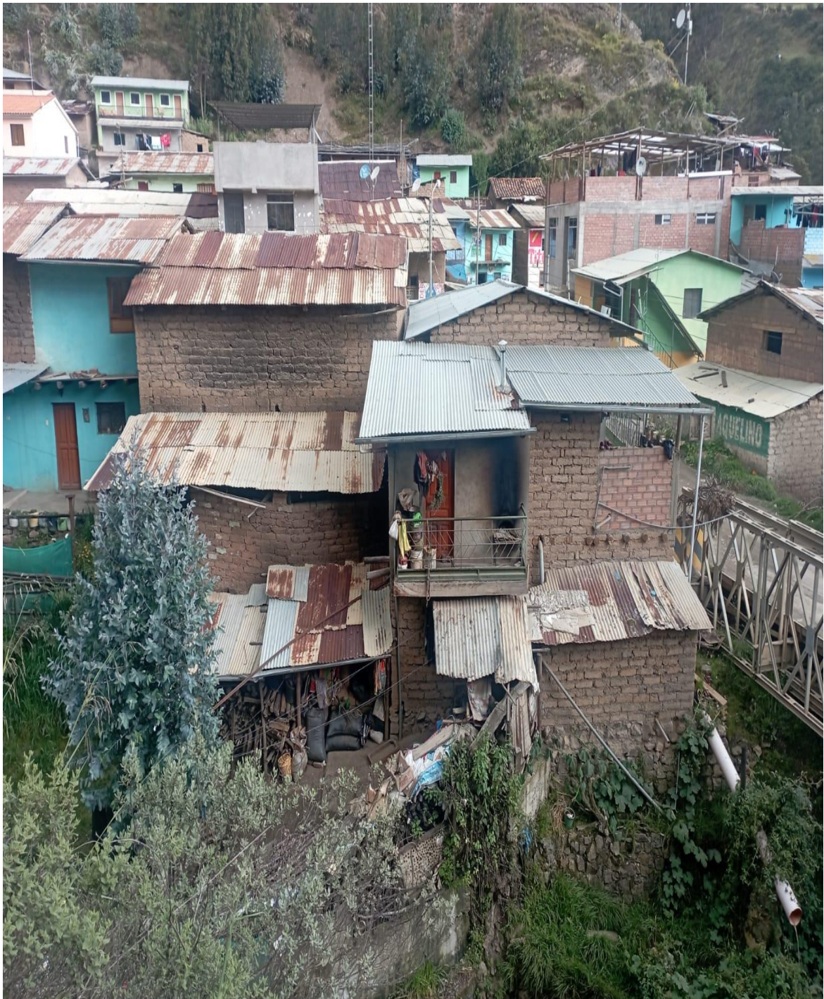
ANEXO 21. Registro fotográfico de Viviendas del caserío del sector de intervenir.
