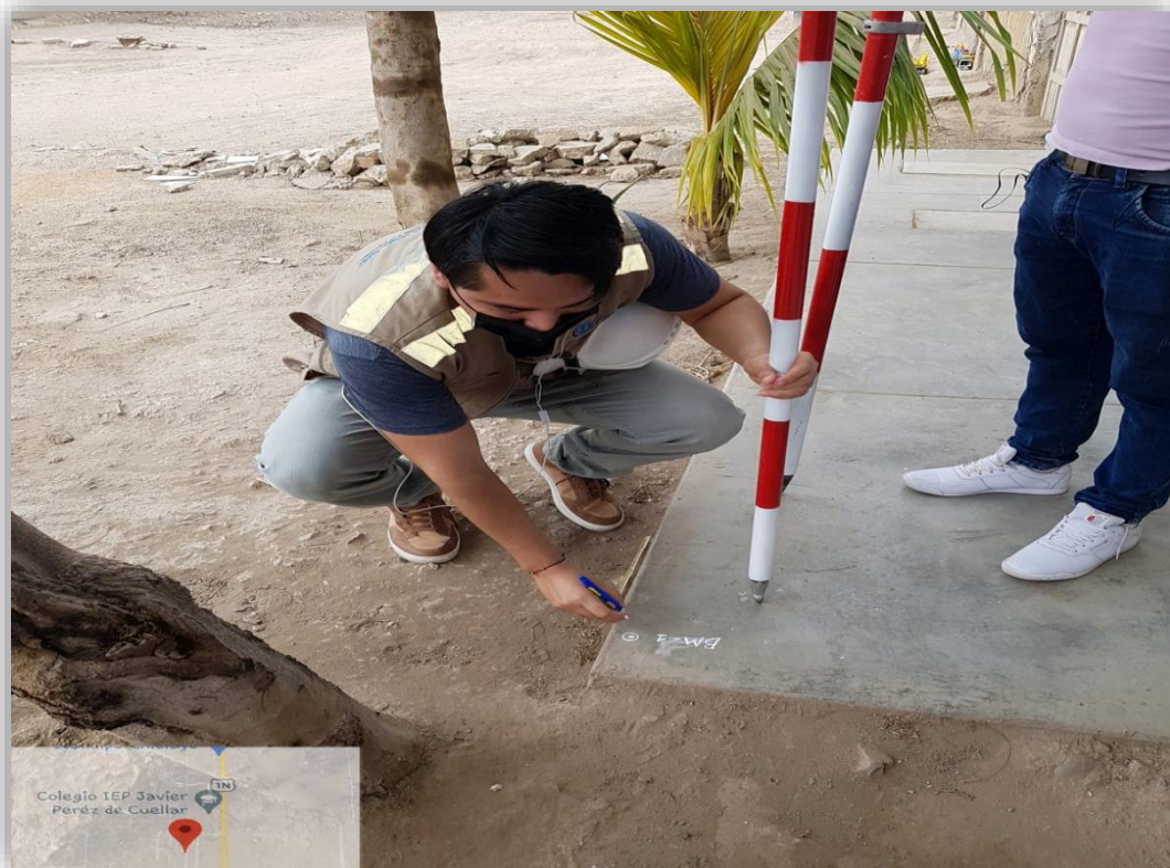
Figura 4. Puntos de control altimétrico (BM)
