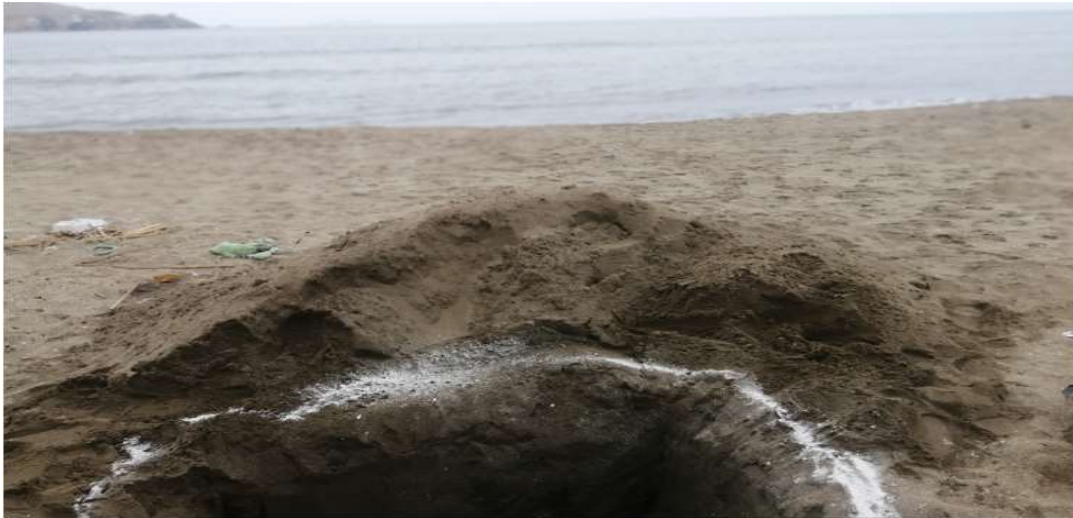
Excavación de la calicata –Urb. Conchitas
