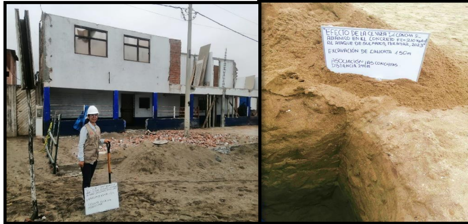
Figura 6: Ubicación y excavación de la calicata
