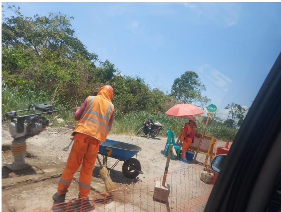
Ilustración 8: Personal Obrero en el Mantenimiento de la Carretera Laberinto - Santo Domingo
