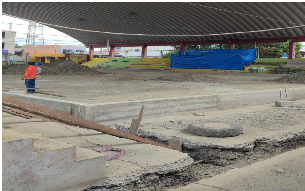
Ilustración 6: Antes de la Ejecución de la Obra de Renovación del Coliseo Municipal
