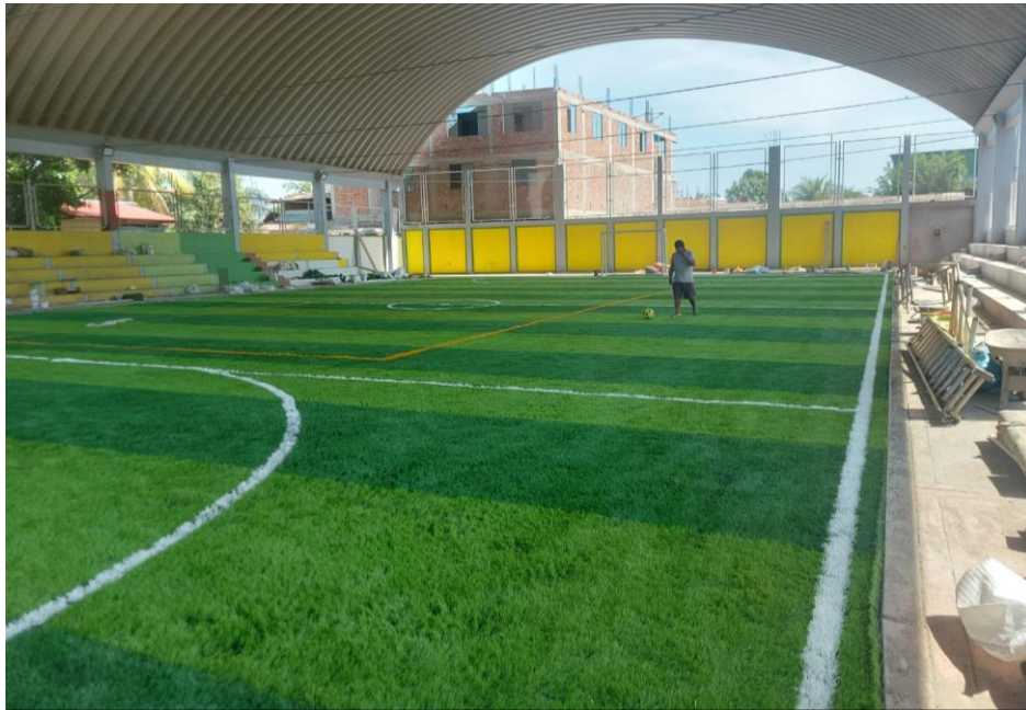
Ilustración 7: Obra en Ejecución de la Renovación del Coliseo Municipal
