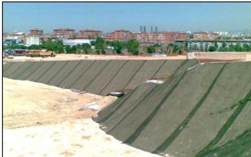
Figura 05. Aplicación de la geomalla uniaxial
