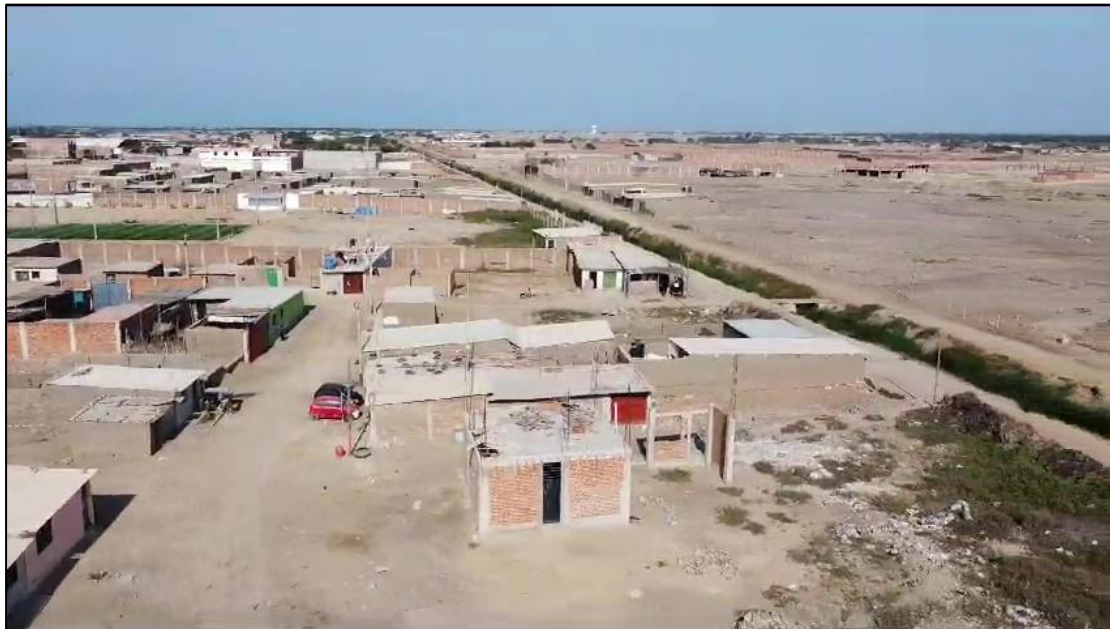
Imagen 14. Vista de la población cerca al DREN existente 2023
