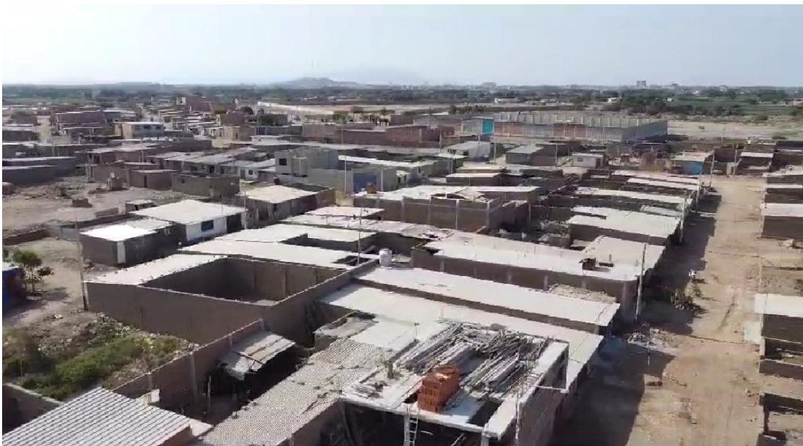
Figura 17. Imágenes de la zona en su totalidad con apoyo de DRON
