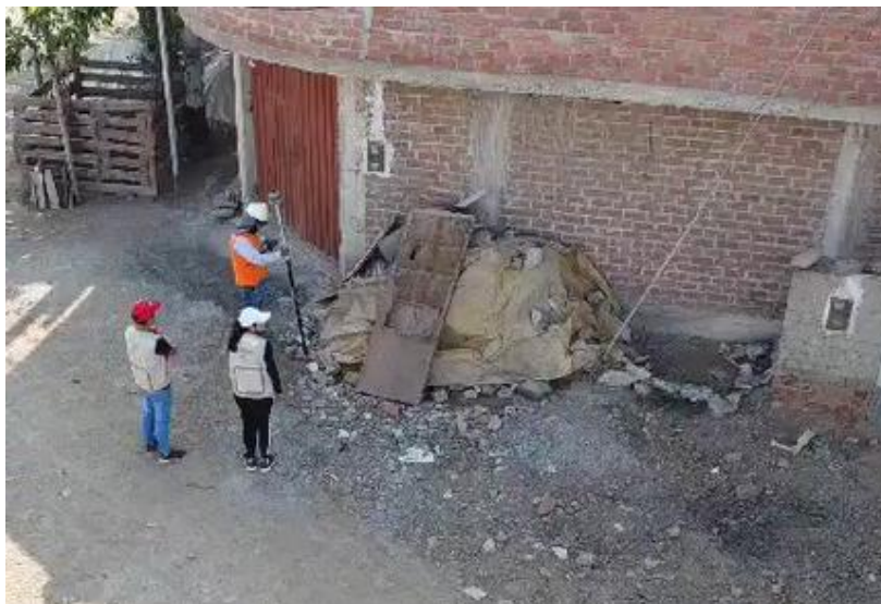
Figura 14. Inspección de la zona a levantar
