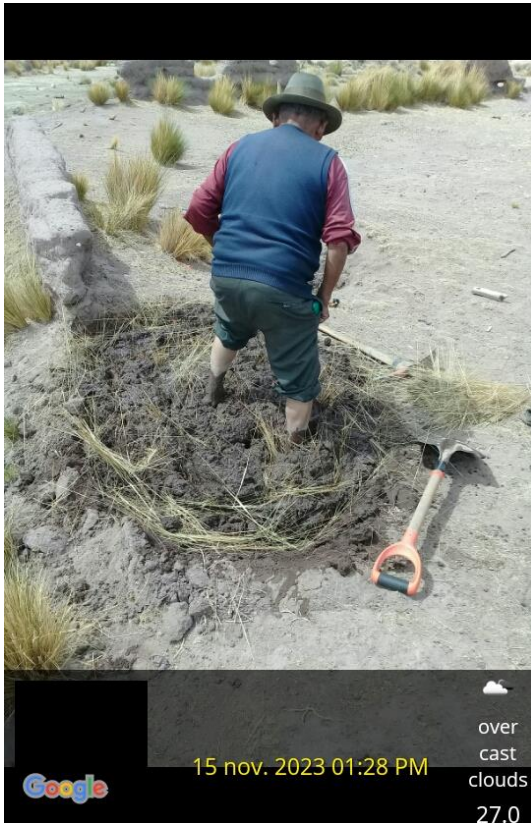
Figura 19. proceso de mezclado de tierra.
