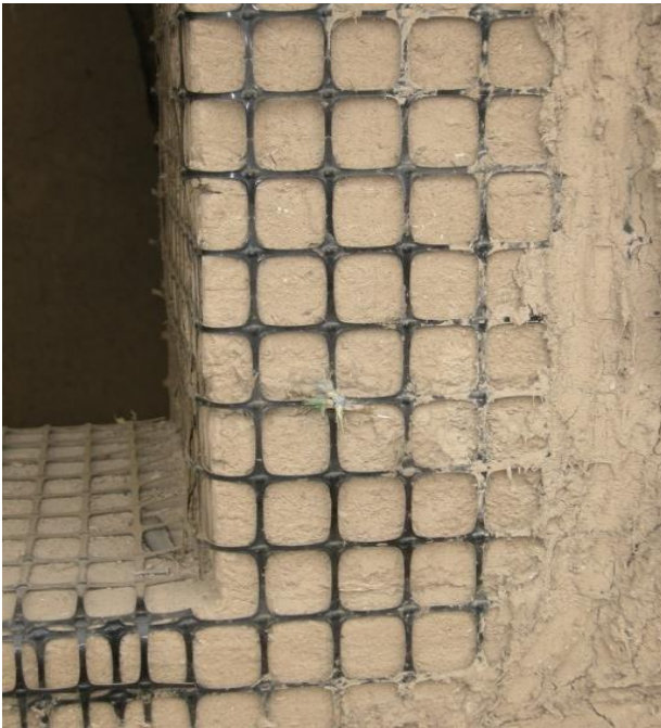
Figura 4. Vista de geomalla en el muro de adobe.
