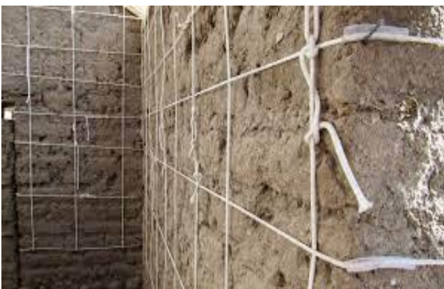
Figura 5. Vista de Drizas en muros de adobe.
