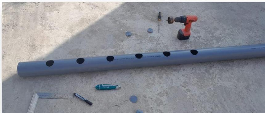
**Figura D.2: Haciendo los orificios de los tubos**
