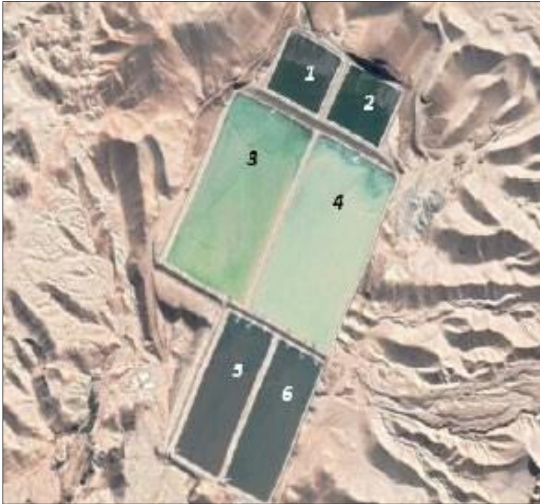
Figura 4. Planta de tratamiento de agua residual Omo - Moquegua.
